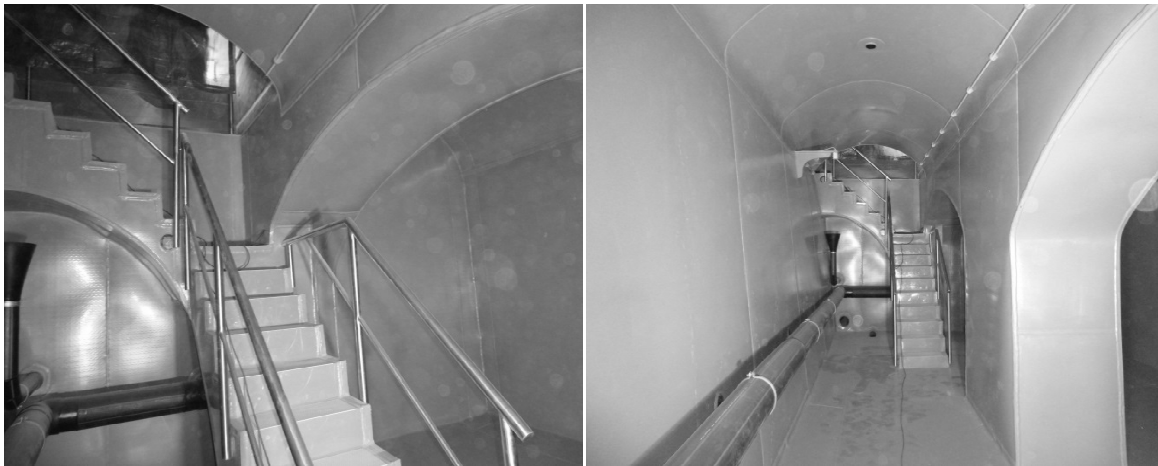
Obr. 1. Konečný stav vodojemu po vyvločkování
